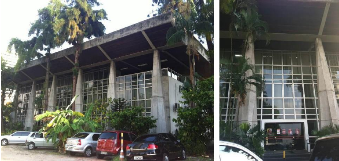
Figura 26 - Prédio original da sede da PR/PA
